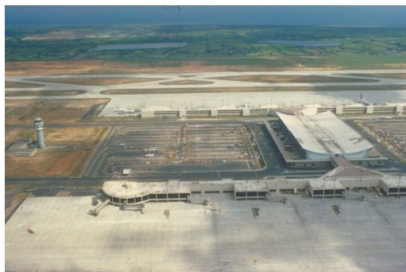
圖2 民國66年施工中的桃園國際機場 案名：中正國際機場、臺灣鐵路工程 檔號：0068/S110/1 來源機關：行政院新聞局 管有機關：國家發展委員會檔案管理局
