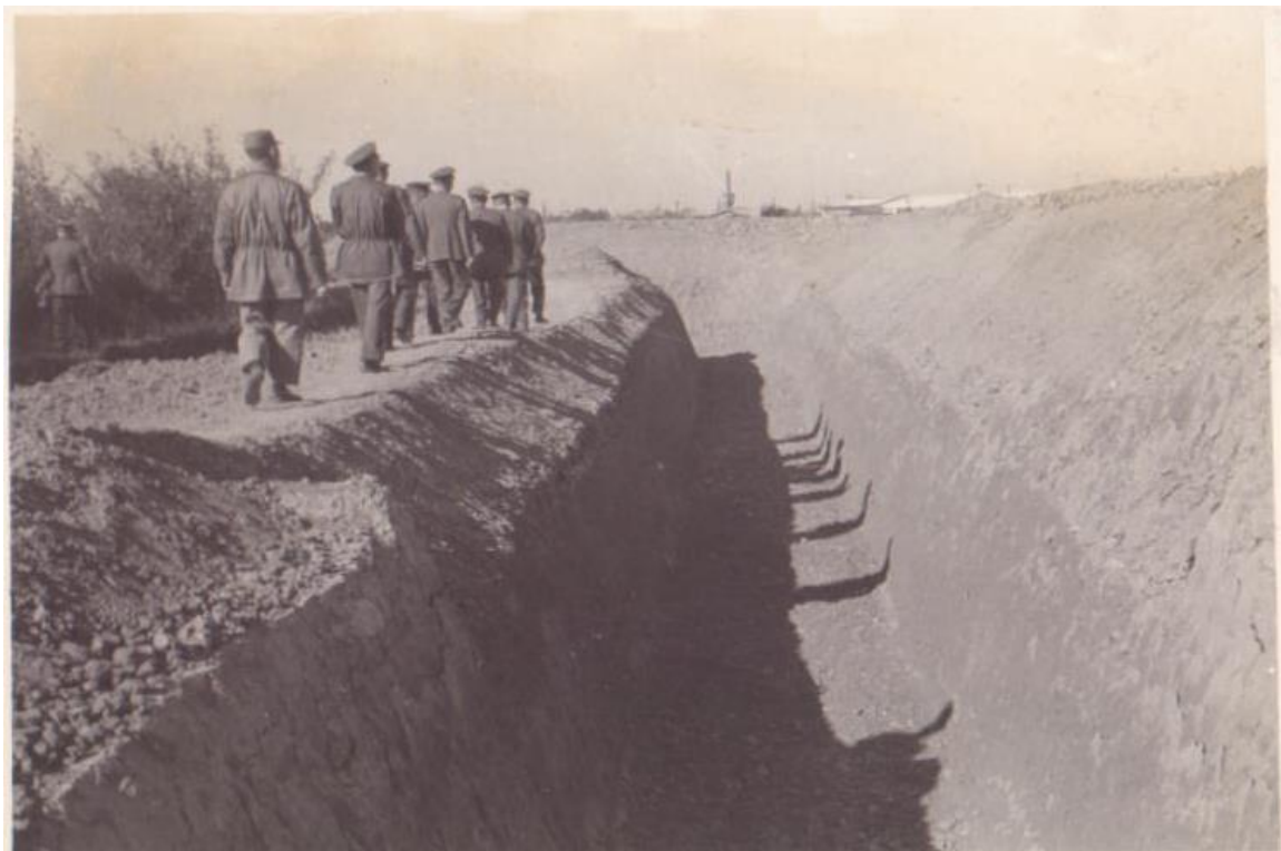
民國 50 年 1 月 20 日通基處為加強營區安全防護於營區四周 構築圍牆及外壕等防禦工事 (檔號：115/013601/3/1/1)
