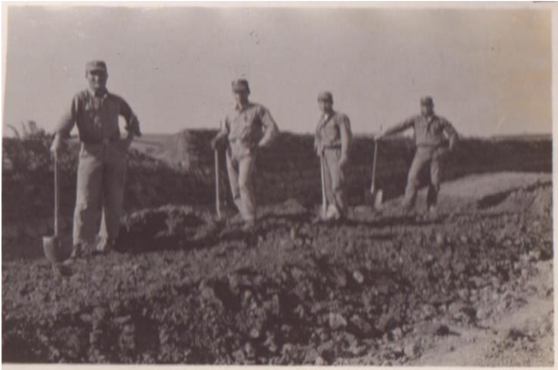
民國 50 年 1 月 20 日通基處為加強營區安全防護於營區四周 構築圍牆及外壕等防禦工事 (檔號：115/013601/3/1/1)
