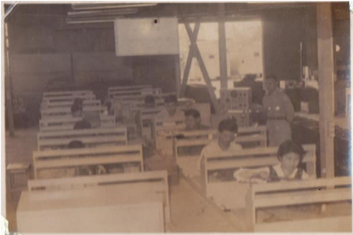
民國 49 年 7 月 20 日於修理工廠維修 SB-22 交換機 (檔號：115/013601/1/1/1)
