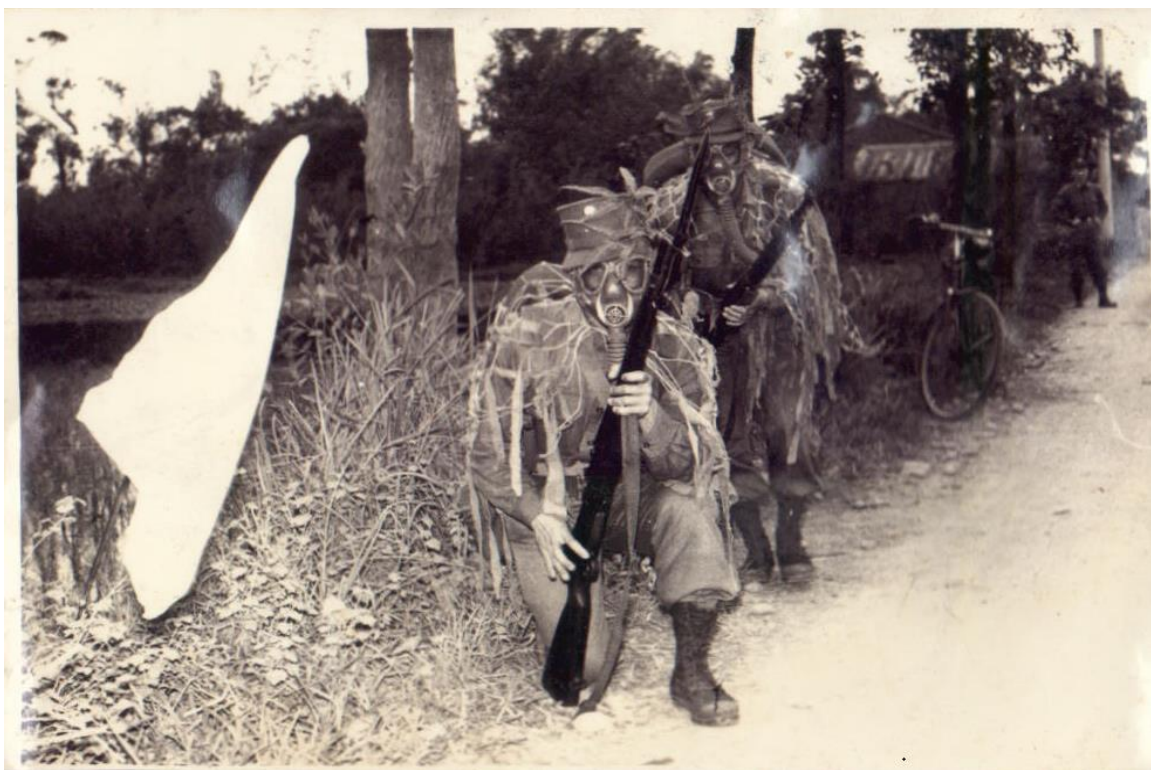
民國 50 年 4 月 5 日通基處於營區周邊實施偽裝戰備訓練 (檔號：115/013601/2/1/1)
